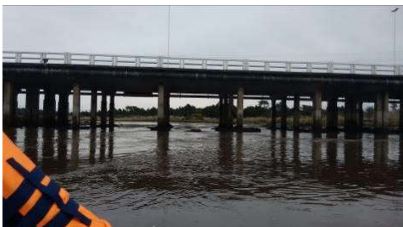
Figura 9.25 Puente sobre la ruta Interbalnearia
