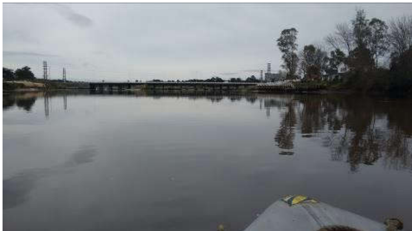
Figura 9.24 Puente sobre la ruta Interbalnearia
